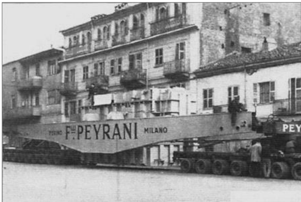
Torino. Passaggio in via Giachino di un trasformatore da 400 Kva destinato a Los Angeles, anni Sessanta (ASTo, Sez. Riunite, ASNOS, Fondo Materiale fotografico, 283)
